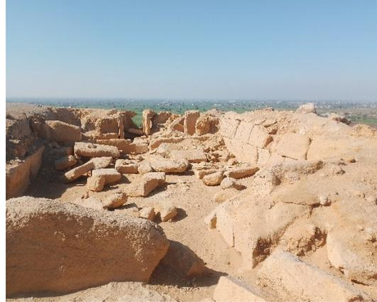
لوحة رقم (١٦) تفتت وتآكل أسطح الحجر الجيري
