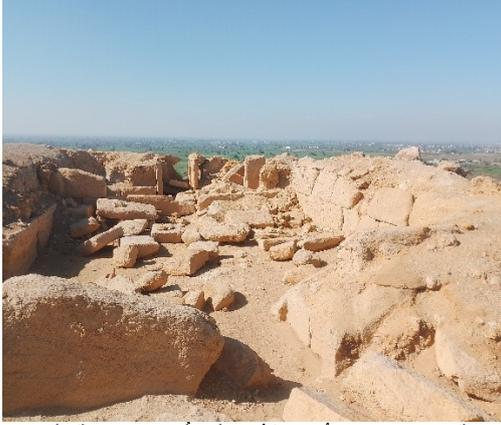
لوحة رقم (١٧) تفتت وتآكل الأسطح الخارجية لأحجار
