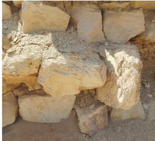
لوحة رقم (٢٠) تآكل وشروخ دقيقة لأحجار الهرم
