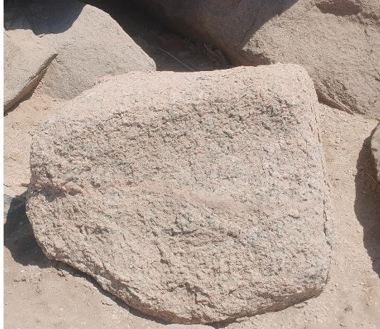
لوحة رقم (٢٠) تقشّر الأسطح الخارجية للكُتل الجرانيتية بالمعبد نتيجة لأشعة الشمس والتغير في درجات الحرارة (تصوير الباحث)
