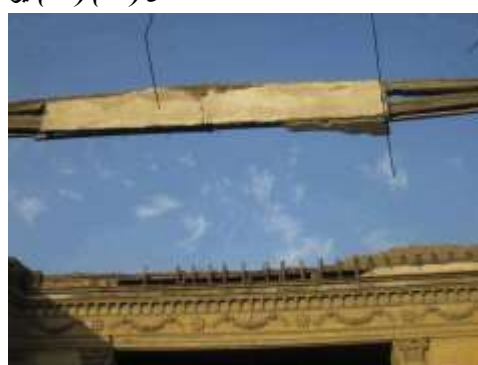
شكل (٣٦) (٣٧) يوضح شكل السقف الجمالوني المتهالك فوق السلم الرئيسي. ٢
