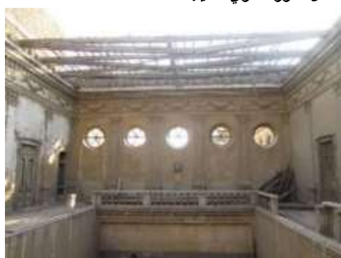
شكل (٣٦) (٣٧) يوضح شكل السقف الجمالوني المتهالك فوق السلم الرئيسي. ٢
