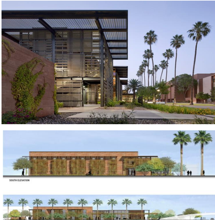
صورة رقم (3) يوضح توظيف عناصر التظليل الخارجية (الكاسرات الشمسية الأفقية والشاشات الخشبية تغطي الواجهات الزجاجية)
