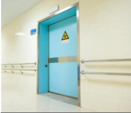
شكل رقم (8) نموذج لأبواب غرف العزل المدعومة بالرصاص نقلًا عن: <https://www.rf-shielded.com/sale-15366810-sliding-x-ray-radiation-protection-door-1-leaf-45db-rf-shielded-doors.html>
