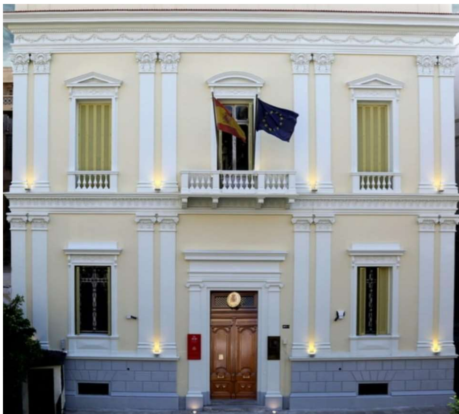
لوحة 8: مبنى المركز الثقافي الإسباني (قصر بيبي سابقاً) - تصوير الباحث
