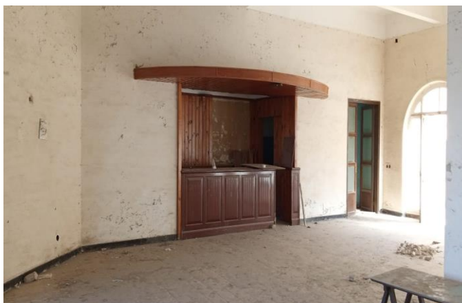
لوحة (١٠) توضح البار الموجود بالطابق الثاني العلوى بمبنى البيت الإيطالي ( تصوير الباحث )
