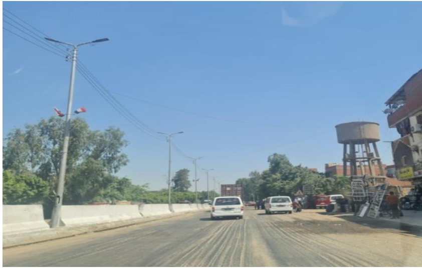
صورة (15) تموجات الطبقة السطحية لأسفلت الطريق بالقطاع الأوسط للطريق بتاريخ 6/5/
