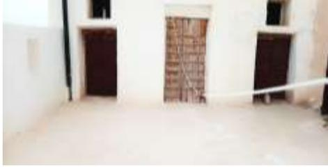
توضح الصورة (21) سطح مكشوف إلى السماء وهو الريم والذي به باب من خشب الحمر مؤدي إلى المرواح والنوافذ الكبيرة التي تعلوها المناور وتدهن حوائط الريم بالنورة البيضاء لكسر أشعة الشمس الساقطة على الحوائط وتقليل الحمل الحراري عليها والذي بدوره يعكس حرارته بداخل المرواح. المصدر (تصوير أ. عبد الله علوي بن سميط)
