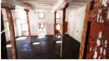
توضح الصورة (20) المرواح ويستخدم لإقامة المناسبات العائلية وإستقال النساء متصلة بنوافذ كبيرة تؤدي إلى الريم مصنوعة من خشب الحمر وتتكون من نوافذ صغيرة تشبه المشربية وتسمى مشارف وتعلو النوافذ المناور لدخول الضوء بالنهار ويسند سقف المرواح أربعة أسهم من خشب الحمر تنتهي من الأعلى بالكباش التي تسند السقف. المصدر (تصوير أ. عبد الله علوي بن سميط)
