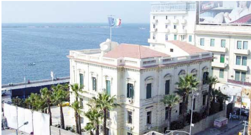
شكل (1) مبنى القنصلية الإيطالية القديمة في شارع فؤاد
