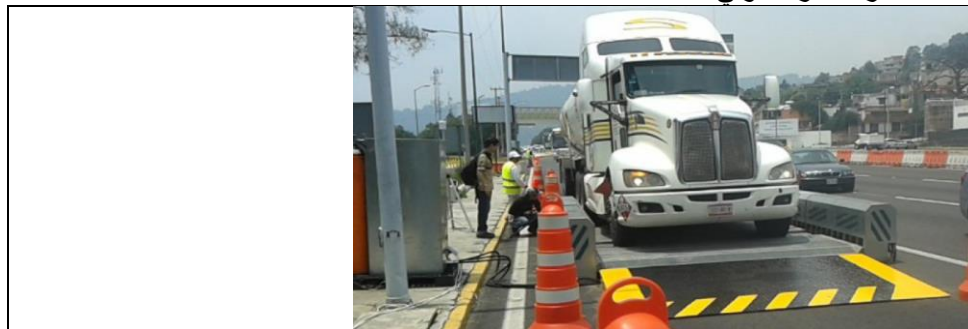
شكل 19 . الشكل يوضح المطبات الصناعية الهوائية التي تحول الطاقة الانضغاطية الي طاقة كهربائية تخزن في بطاريات لاعاده الاستخدام، وهذه التقنية هامة جدا في مداخل المطارات وساحات الانتظار والتي بإمكانها تعمل علي توليد العديد من الطاقات المفقوده .
