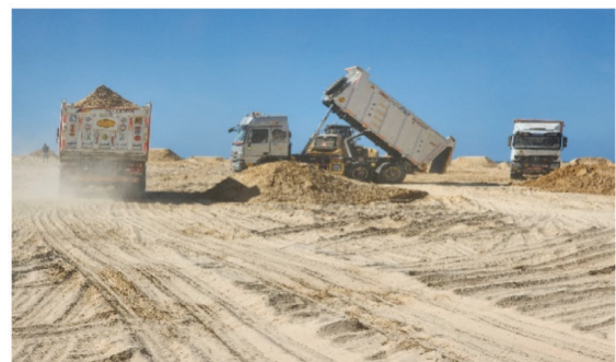
المصدر: دراسة ميدانية، ميناء العريش البحري، إبريل، ٢٠٢٤ صورة (٢) أعمال التطوير بالمنطقة المحيطة لميناء العريش
