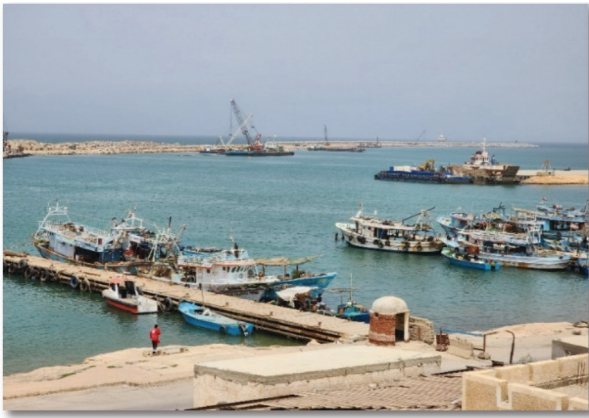
المصدر: دراسة ميدانية، ميناء العريش البحري، إبريل ٢٠٢٤ صورة (٢) الحوض القديم لميناء العريش ناظرة صوب الشمال
