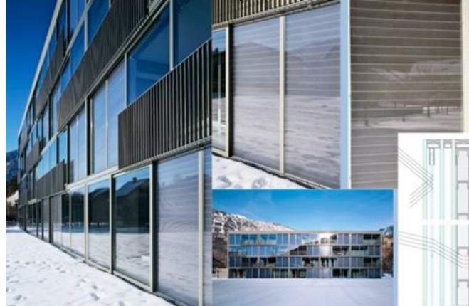
صورة ٤ توضح واجهة مبني sur Falveng حيث الواجهة المغطاة بالزجاج متغير الطور .
