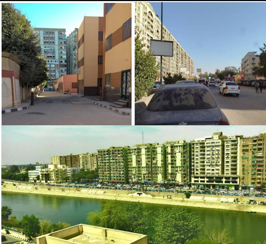
صورة (٢) نمط ارتفاع المباني السكنية حول مستشفى الصدر بمدينة اسيوط عام ٢٠٢٣
