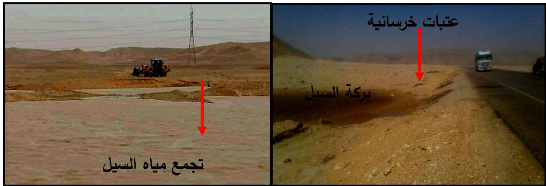
صورة (٩) استخدام العتبات الخرسانية. صورة (١٠) الوسائل الميكانيكية واثرها حجز مياه السيول.
