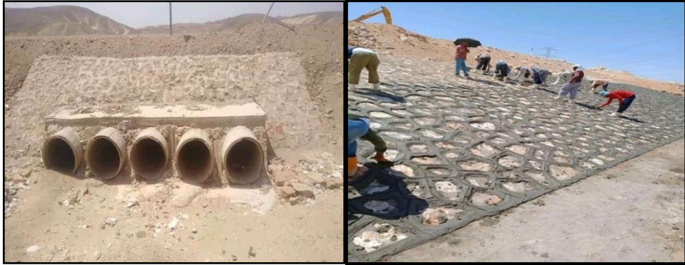
صورة (٧) استخدام البرابخ لصرف مياه السيول. صورة (٨) تغطية جوانب مخرات.
