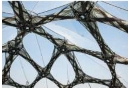
صورة (١٩) هيكل معرض BUGA Fibre Pavilion .
