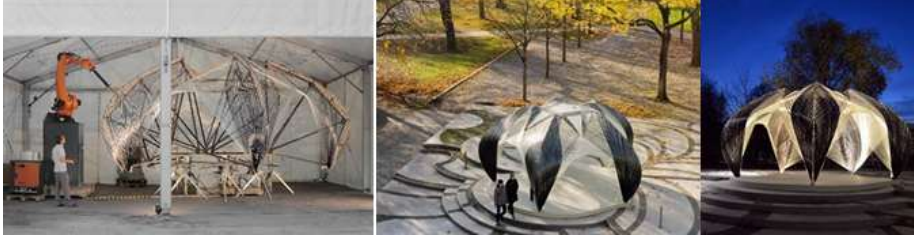
صورة (٣) لقطات من تصميم جناح معهد التصميم بالحاسب الآلي بجامعة ستوتغارت بألمانيا ويظهر فيه استخدام ألياف الكربون ودمجها مع الألياف الزجاجية وتصنيعها من خلال ربوتات التصنيع الرقمي . (إسماعيل .٢٠١٧. ص ٤٢)
