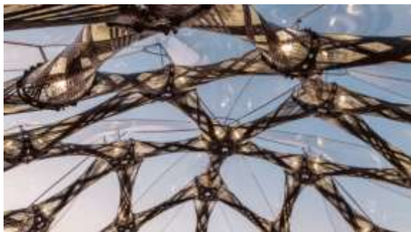
صورة (١٨) هيكل معرض BUGA Fibre Pavilion .
