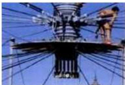
صورة (١١) الوحدة المجمعة لشد الكابلات الشادة للهيكل الغشائية الممتدة. (مصطفى وأبو العزم، ٢٠٢٢، ص ٣٠)
