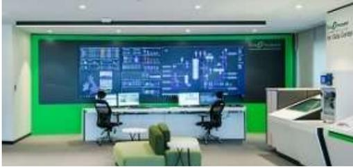
حيث يتوفي بالمبنى أحد سمات الذكاء وهى الأتمتة عن طريق توافر نظام إدارة المبنى (BMS) الذى يتحكم بأنظمة المبنى مثل: (أنظمة تكييف الهواء المركزى- الإضاءة الصناعية- التحكم الأمتي-المصاعد..وغيرها) .
