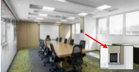
يتحكم في درجة الحرارة داخل الحيز و يوفر راحة للأشخاص الموجودين، ويهدف إلى تحسين كفاءة الطاقة من خلال الأجهزة و الحساسات التي تعمل معاً لضبط درجات الحرارة بطريقة ذكية ويرتبط أيضاً بنظام إدارة المبنى .
