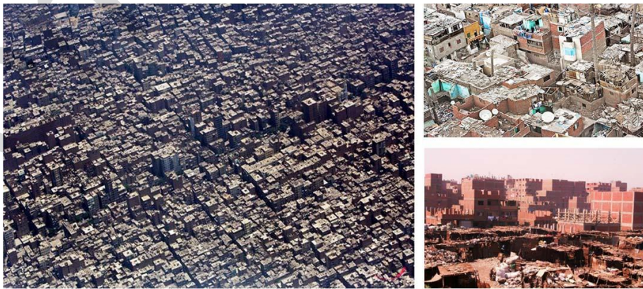
(ب) النمط العمراني ونقص الفراغات العمرانية وتهالك البنية
