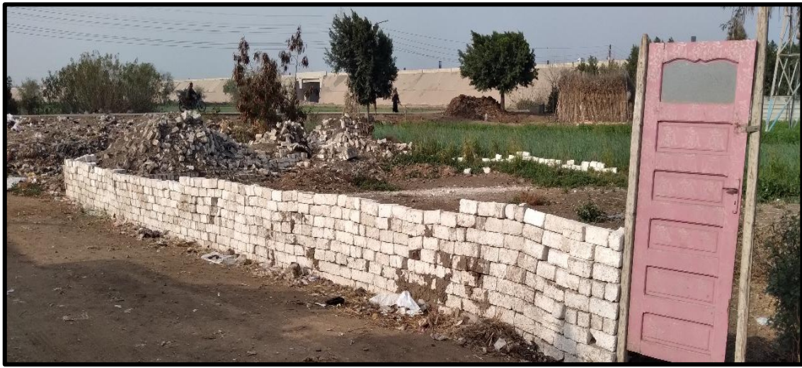
صورة (١٠): محاولات التسوير والتبوير للأراضي الزراعية بالقطاع الجنوبي غرب طريق شبرا - بنها الحر بقسم قها تمهيدا للبناء عليها، ظاهرة منتشرة بمنطقة الدراسة.
