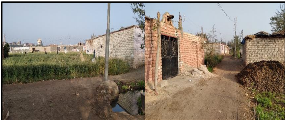
صورة (١١): مباني مخالفة بالبناء على الأراضي الزراعية تم استخراج شهادة تصالح لها بالقطاع الجنوبي غرب طريق شبرا - بنها الحر، مشهد متكرر على جانبي الطريق من بدايته عند قريتي كوم أشفين وميت حلفا بمركز قليوب حتى قريتي منية السباع ومنشأة بنها بمركز بنها.
