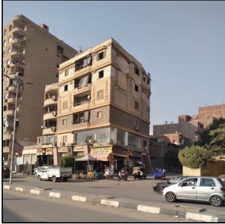
صورة (١) : المدخل الجنوبي الرئيس : تقاطع شارع الجزائر مع شارع ٥٠٠ وتظهر عمارة تم إزالة بعض أجزاء من الطابق الخامس والطابق السادس من قبل الهي ثم تم إعادة بنائهم كما يتضح بالصورة.
