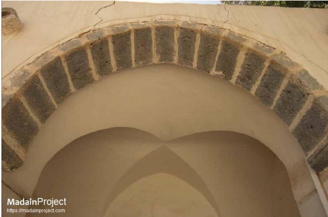
لوحة رقم (٤) توضح تفاصيل عقد مدخل مسجد الفتح (٩٥)
