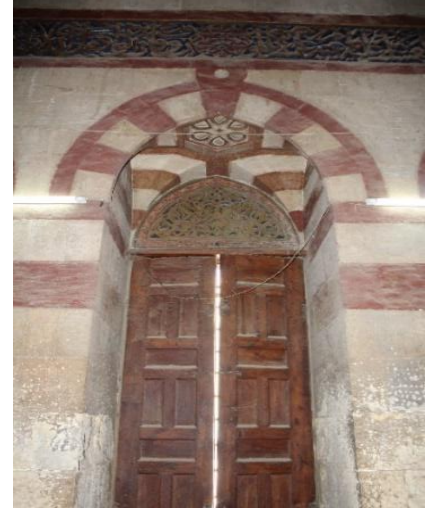
لوحة رقم (10) أساليب تغطية الشبابيك منالداخل بمدرسة قايتباي بالقرافة الشرقية
