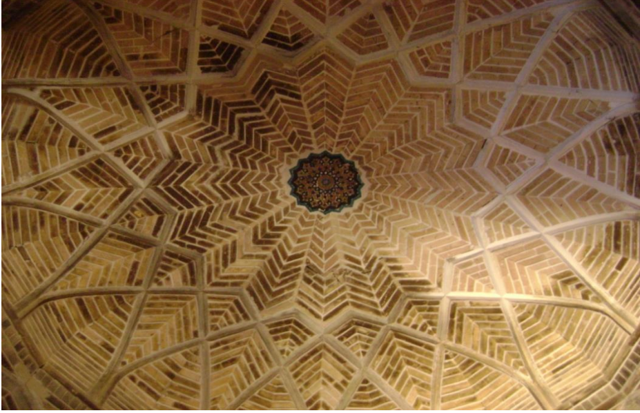
(لوحة ٥) باطن قبة دركاة المدخل بمدرسة ميرا عرب
