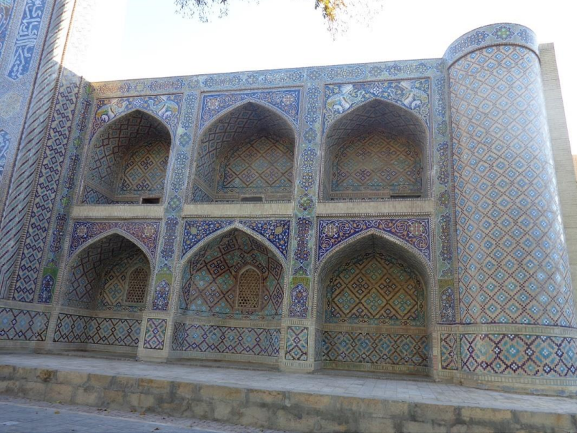
( لوحة ٣ ) الضلع الشرقي من الواجهة الرئيسية بمدرسة نادر ديوان بيگي
