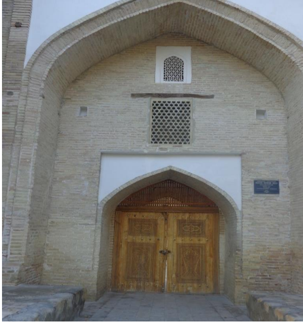
( لوحة ٤ ) حجرالمدخل الرئيسي بالواجهة الرئيسية بمدرسة نادر ديوان بيگي.
