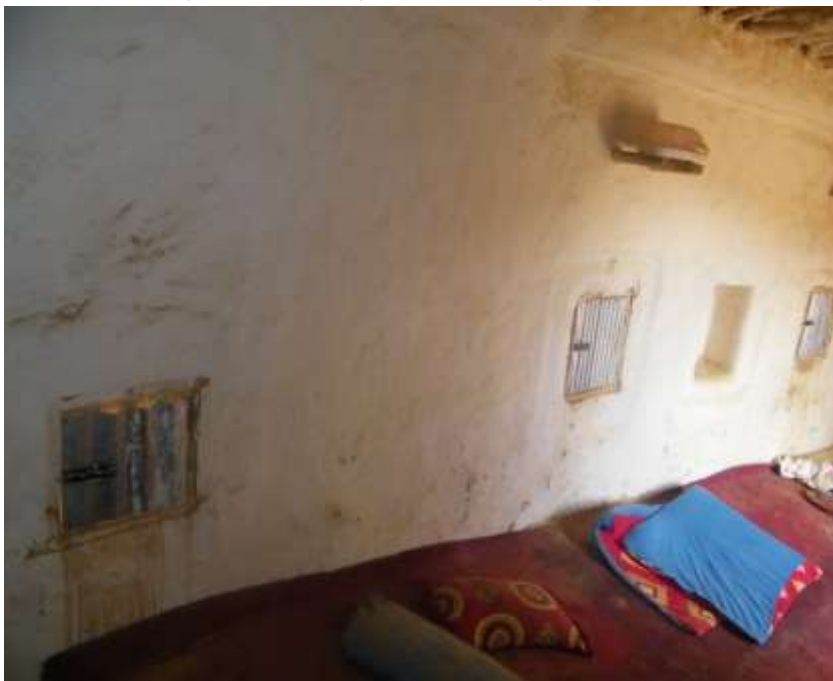
لوحة ( ٢٠ ) فتحات الشبابيك بالدرب الصيفى ( تصوير الباحث )
