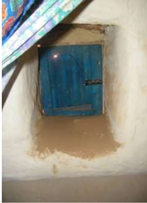
لوحة (١٥) فتحات الشبابيك بالدرب الصيفى ( تصوير الباحث )
