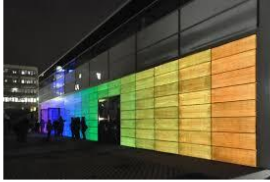
شكل رقم (٦) يوضح شكل الخرسانة الناقلة للضوء ليلاً
