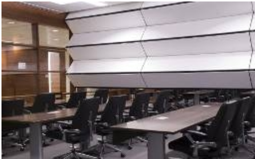
(شكل 7-ب) سقف معلق يحتوى على فراغ يتم تخزين قاطوع متحرك داخله
