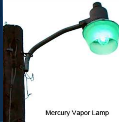
الشكل (11) أمثلة على مصابيح التفريغ عالية الكثافة (HID)
