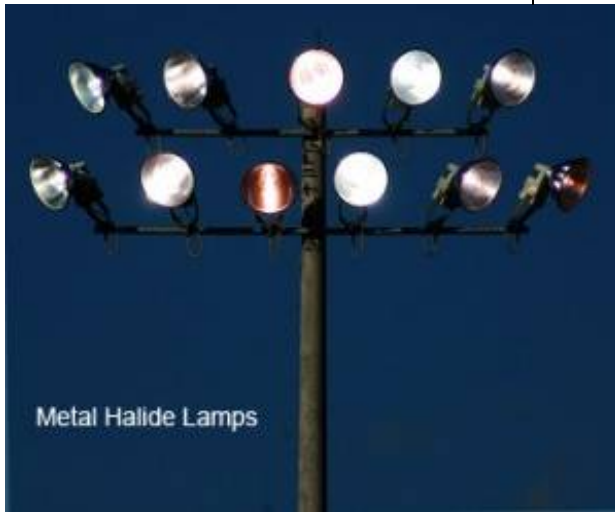
الشكل (11) أمثلة على مصابيح التفريغ عالية الكثافة (HID)
