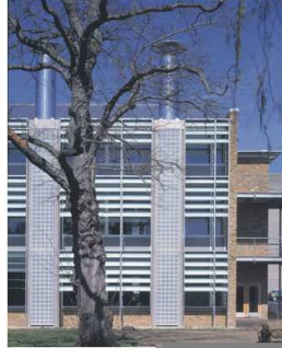
شكل (١٢): المداخل الشمسية في المبنى الإداري في مؤسسة أبحاث البناء ، إنجلترا.
