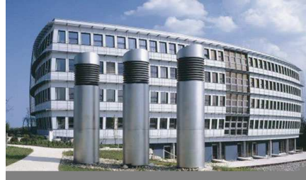
شكل (٨): مأخذ الهواء للتهوية والتبريد خارج المبنى الإداري السلبي Energon في أولم، ألمانيا. المصدر: الوكالة الدولية للطاقة (IEA)
