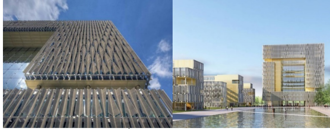
شكل (١٠): مبنى Q1 الألماني
