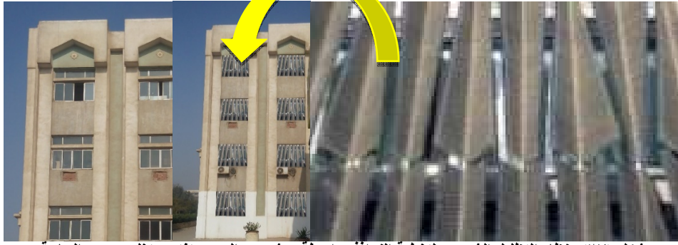
شكل (٢٧): نظام التظليل الشمسي لتغطية النوافذ بواسطة ريش من المعدن تفتح وتغلق حسب الحاجة
