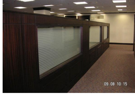
صورة رقم (٥) توضح تركيب أحد القواطع الخشبية.
