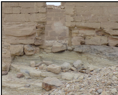
صورة (٢٥) : نحت واجهات المباني الأثرية بفعل الرياح بمعبد الناصورة بالخارجة.
