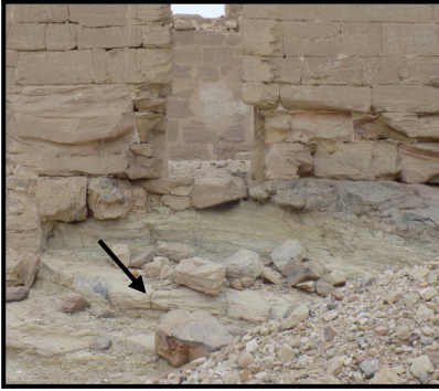
صورة (٥) : إنهيار وسقوط الأحجار الأثرية في معبد الناصورة بالخارجة.
