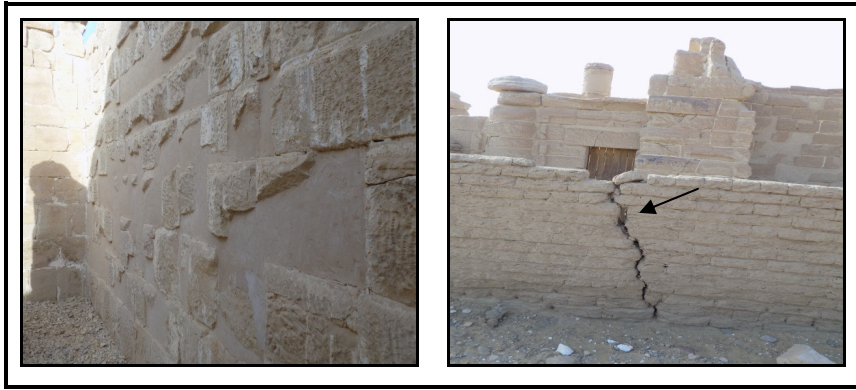
صورة (١٨) : أثر الرطوبة على طمس وإنهيار جدران معبد دير الحجر بالداخلة.
