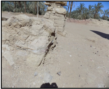
صورة (٢٤) : نحت الرياح لواجهات وأعمدة معبد هيس بالخارجة.
