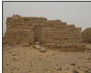
صورة (٢٥) : نحت واجهات المباني الأثرية بفعل الرياح بمعبد الناصورة بالخارجة.
