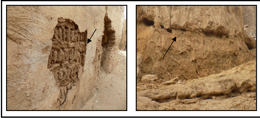
صورة (٢٠) : التأثيرات الفيزيائية للرطوبة على المباني الطينية بموط القديمة بالداخلة.
