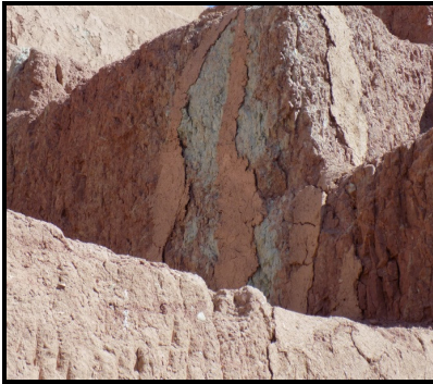
صورة (٩) : أثر التجوية الفيزيائية على الجدران الطينية لقلاع الضب بالداخلة.
