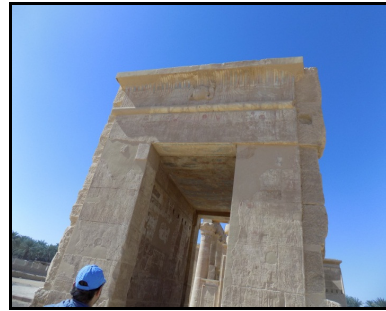
صورة (٢٤) : نحت الرياح لواجهات وأعمدة معبد هيس بالخارجة.
