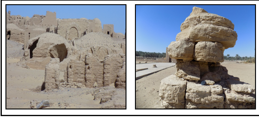
صورة (٢٦) : نحت وهدم الرياح لجبانة البجوات بالخارجة.
