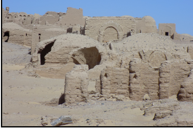
صورة (٢) : إنفصال وإنهيار جدران جبانة البجوات بالخارجة.
