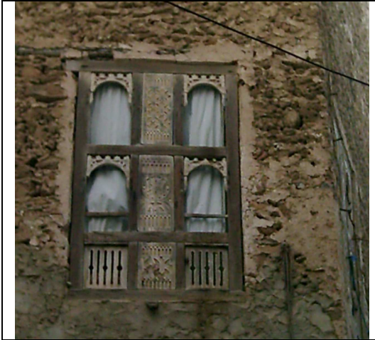
شكل رقم 9: واجهة تساقطت عنها مادة اللياسة النورة و تكشفت من تحتها حجارة الخرشيح التي بنيت منها كثير من البيوت البرجية في مدينة المكلا.
