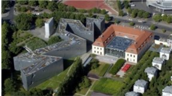
(شكل ١) المبنى التاريخي القديم لمتحف "برلين" والملحق الجديد الخاص بعرض أعمال المجتمع اليهودي في "برلين"
