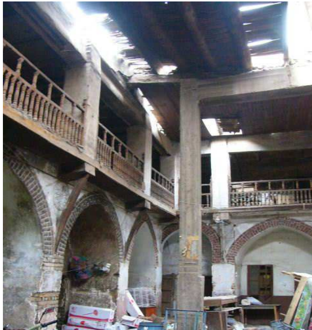
شكل رقم (4): أعمال الترميم بوكالة ثابت التراثية بمركز أسيوط القديم (القيسارية) بأعمدة من الخرسانة.
