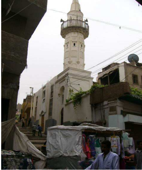
[ب] إشغالات تجارية رديئة تحجب مدخل المسجد القديم بالمنطقة.
