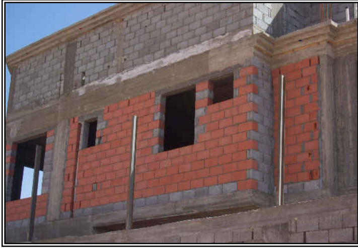
شكل رقم 10: صورة تبين استخدام الطوب الأحمر والطوب الأسمنتي العادي بطريقة غير سليمة من خلال حائط واحد به أعمدة وكمرات وأعتاب خرسانية غير معزولة.
