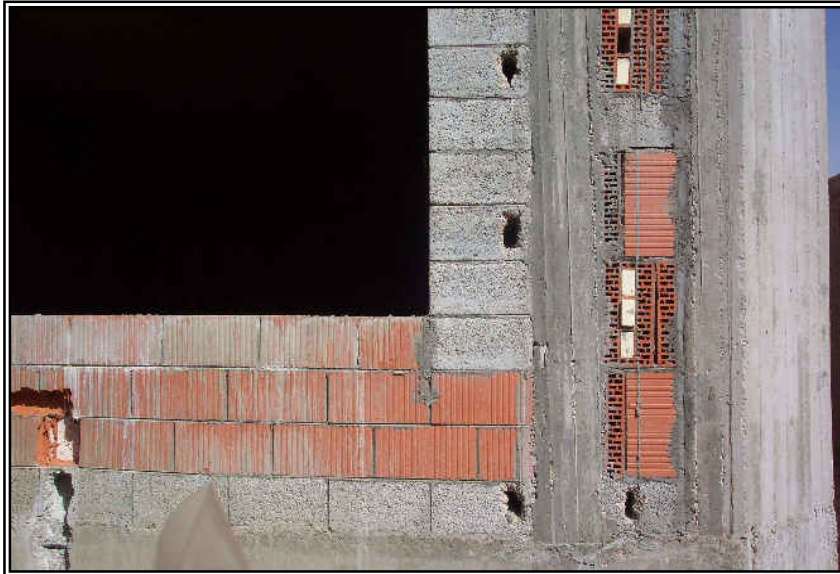
شكل رقم 8: صورة لحائط خارجي تبين الاستخدام الخاطي للطوب الأحمر من قبل المقاول.
