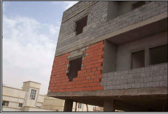
شكل رقم 9: استخدم المالك الطوب الأحمر في جزء من الدور الأول بينما استخدم الطوب الأسمنتي العادي بالدور الثاني.
