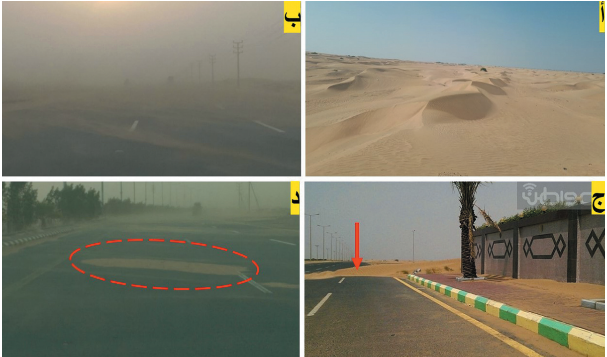
الشكل ٢. مخاطر الزحف الرملي في منطقة الدراسة: أ- بيئة رملية مصدر العملية، ب - قلة في مجال الرؤية لبعض الأجزاء من الطريق الدولي الساحلي، ج - تراكم الرمال المتحركة على الطريق (الكيادي، ٢٠١٨ مع التعديل)
