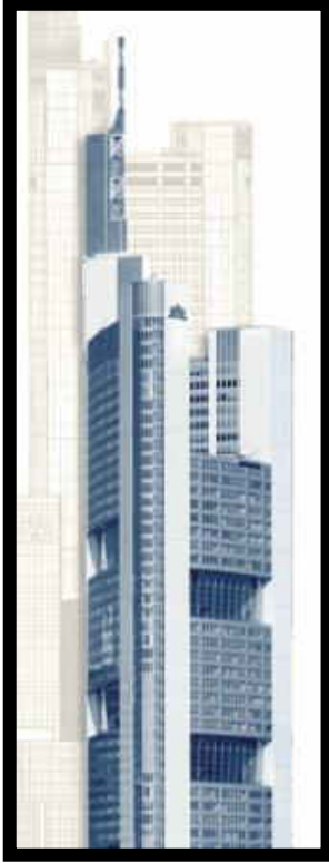
شكل (12) : إستخدام الـ Vierendeel beams فى واجهات المبنى [11].
