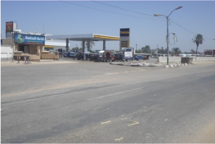
صورة (8) محطة دينا توفيق على طريق بني سويف/ المنيا بمركز ببا المصدر: الدراسة الميدانية يوم الأربعاء 2016/8/10
