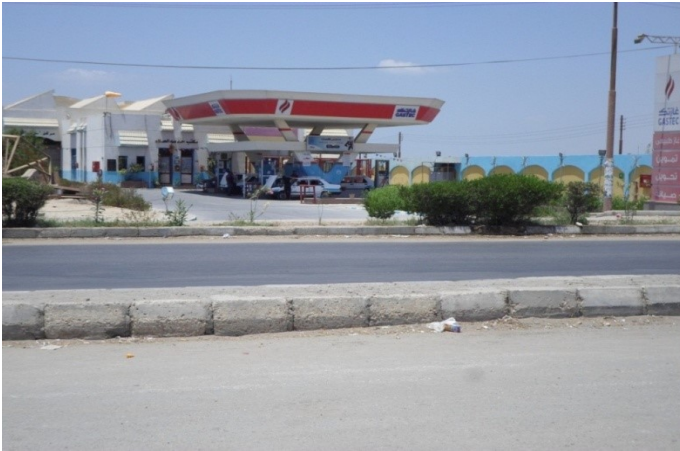
صورة (11) محطة غازتك على طريق القاهرة/أسيوط الصحراوي الشرقي بمركز بني سويف المصدر: الدراسة الميدانية يوم الثلاثاء 2016/6/28
