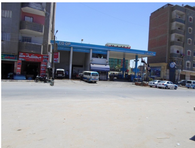
صورة (6) محطة أحمد محمد توفيق على طريق بني سويف/ المنيا بمركز بني سويف المصدر: الدراسة الميدانية يوم السبت 2016/7/16
