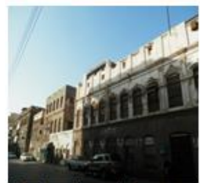
شارع تصطف فيه كتل المباني السكنية التقليدية في ارتفاعات متناسخة ومفردات تحاكي بعضها وألوان متناسخة
