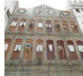
واجهة يظهر فيها مادة البناء الأساسية (الحجر) والفتحات المستطيلة رأسياً ومادة الملء (الخشب) وخط السماء المتميز
