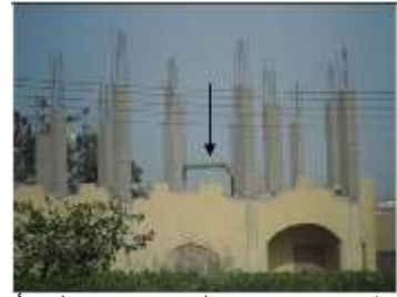
شكل (65): صورة لمسكن قام بعمل الأعمدة والسلم تمهيديا لتعليية المسكن ويشير السهم إلى مكان السلم [25]
