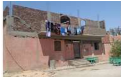
شكل (63): صورة من واجهة الحوش لمسكنين تم دمجهما وتعليتهما [25]
