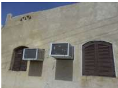
شكل (30): صورة لانتشار استخدام أجهزة التكييف في الطارف الجديدة [25]
