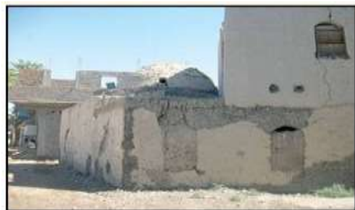
شكل 13 صورة لأحد بيوت القرنة الجديدة به شروخ كبيرة وتم سد فتحات الشبابيك بالدور الأرضي [25]
