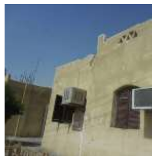
شكل (29): صورة لانتشار استخدام أجهزة التكييف في الطارف الجديدة [25]
