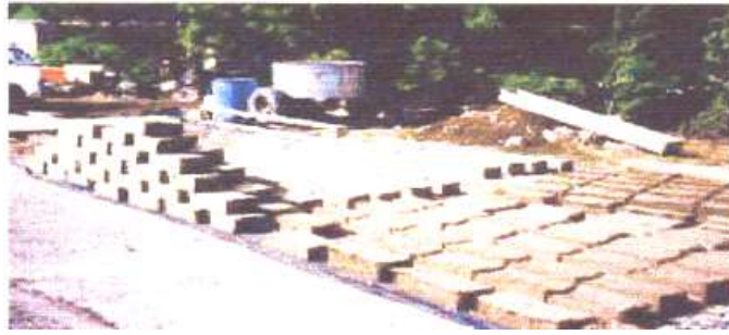
شكل (9): طريقة تجفيف بلوكات القش والطين العازلة للحرارة بطريقة تبادلية في الهواء الطلق.
