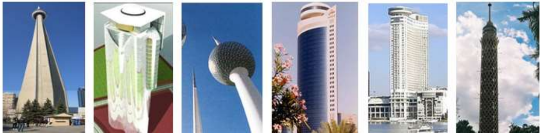
شكل (16): بعض المشاريع المعاصرة التي تناولت بداية فكر الحركة عن طريق دوران بعض ادوار المبنى لإمتاع مريديها بالإطلال الكامل على الخارج والاستمتاع بالمنظر الخارجي- [26]
