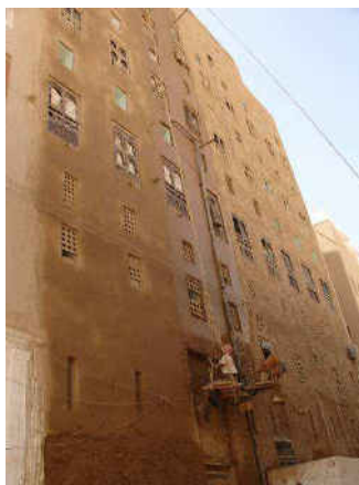
شكل ١٣: لياسة الجدران الخارجية بالطين (المحضة)
