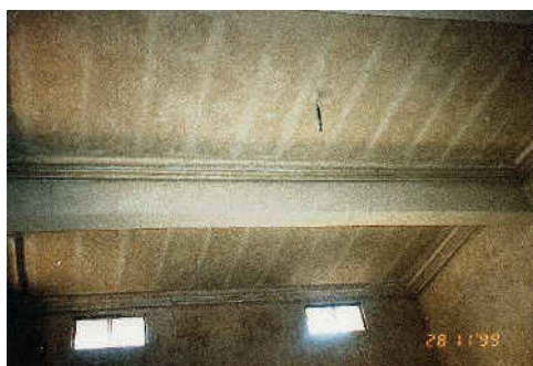
شكل ٧: استخدام الخرسانة المسلحة في بناء السلالم و الجسور لإطالة بحر الأسقف في العمارة الطينية.
