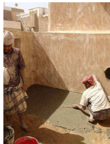
شكل ١٢: إنهاء السقوف حديثًا بمادة الأسمنت بدلا من النورة.
