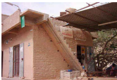
شكل ٧: استخدام الخرسانة المسلحة في بناء السلالم و الجسور لإطالة بحر الأسقف في العمارة الطينية.
