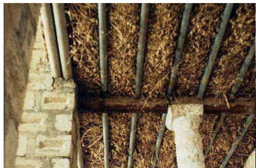
شكل ٦: استخدام مواسير المياه الشبيهة بأعواد الأشجار ذات الأقطار الدائرية في تسقيف المباني الطينية، كما يلاحظ استخدام الطوب الخرساني بدلا من الطوب الطيني في بناء الأعمدة.
