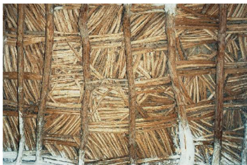
شكل ٥: منظر لسقف تقليدي من الداخل تظهر فيه أعواد العلب و نباتات العشر معمولة بطريقة زخرفية بديعة.
