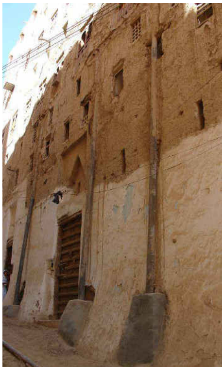
شكل ١١: إسناد الجدران بواسطة أعمدة خشبية - معاتن من الخشب - الصورة إلى اليمين، و استخدام المواسير الحديدية حديثًا ذات الأقطار الكبيرة كمعاتن.
