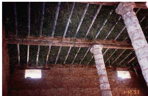
شكل ٦: استخدام مواسير المياه الشبيهة بأعواد الأشجار ذات الأقطار الدائرية في تسقيف المباني الطينية، كما يلاحظ استخدام الطوب الخرساني بدلا من الطوب الطيني في بناء الأعمدة.
