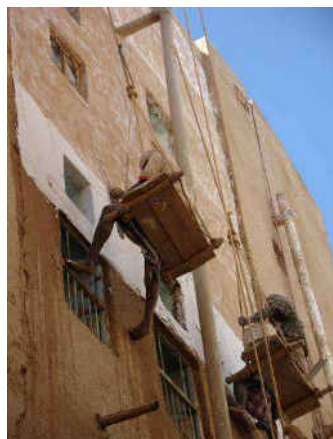
شكل ١٤: تبييض إحدى الواجهات بالنورة.
