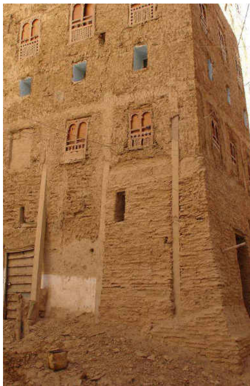
شكل ١١: إسناد الجدران بواسطة أعمدة خشبية - معاتن من الخشب - الصورة إلى اليمين، و استخدام المواسير الحديدية حديثًا ذات الأقطار الكبيرة كمعاتن.
