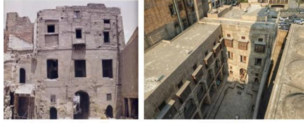
شكل (15): إعادة بناء الأجزاء المتهدمة من خان الزراكشة بالقاهرة التاريخية [12]
