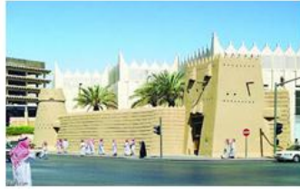
البوابة بعد إعادة البناء
