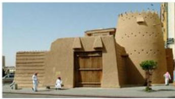
البوابة بعد إعادة البناء
