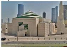
شكل (6): مسجد العزيز، أبو ظبي، الإمارات العربية المتحدة، المصدر: http://arcfly.blogspot.com/2015/10/unique-light-transmitting-concrete.html
