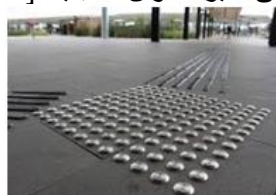
شكل (8): تقنية البلاطات البرزء باستخدام مادة الحديد بلونها الأصلي وتشبيها على الأرضية المصدر: Mizuno, Tomomi, (2008)
