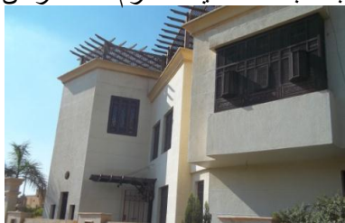
شكل (2): استخدام المشربيات لتوفير الخصوصية البصرية، فيلا رقم 136 المنطقة الخامسة، الحي الأول، التجمع الخامس، القاهرة.
