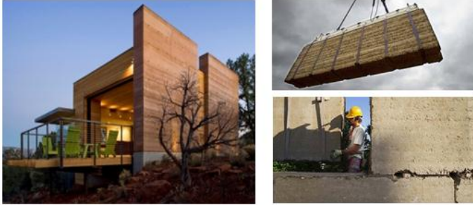
شكل رقم (12): استخدام التقنيات الحديثة في البناء بالطين في مبني بأستراليا [25]
