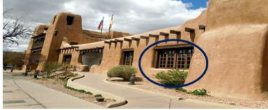
شكل رقم (13): يوضح تدعيم المباني الطينية بجسور خشبية ساهمت في تحسين مساحة وشكل فتحات المبني في مدينة سانتافييه عاصمة نيو مكسيكو [12]
