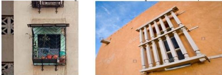
شكل رقم (14): أمثلة لإستخدام عناصر خشبية ومعنوية في عمل كاسرات شمس في هياكل مباني طينية [12]
