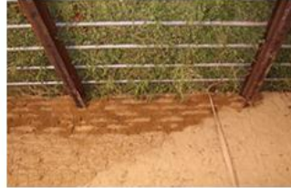
إستخدام كمرات وعوارض معدنية في أسقف المباني الطينية بوادي حضرموت اليمن الممتد
