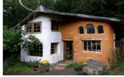
شكل رقم (15): فكرة حماية الجدران الطينية بسقف بارز [26]
