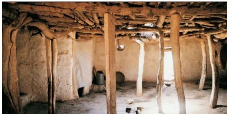
صورة (8) المغرب بلدة Ibouharen-Fahsa قبل فصل منطقة اقامة السكان عن منطقة تربية الحيوانات – اتقان التقنية تظهر فى استخدام اعمدة من الاشجار فى مساحة عضوية وكبيرة نسبيا تحت سقف مضغوط ومسطح، هذا الاسلوب لازال قائماً حتى الان رغم ندرته.
