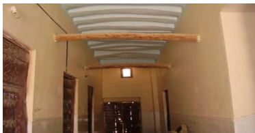
شكل رقم (11): يوضح استبدال أخشاب الأسقف المستخدمة للجسور الأساسية والعرضية بجسور معدنية من الحديد وعوارض من مواسير المياه وتغطيتها بفروع الأشجار والطين [8].
